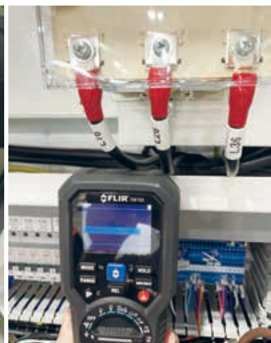
圖三 帶電感應檢測
