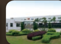
中台廣州塑膠機組裝廠
